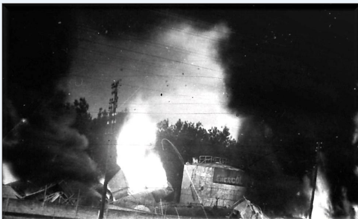
Source : M. Thierry STUCK - Dépôt de carburant de Nomexy suite au bombardement du 31 août 1944
